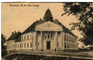
20504. ☒ 1921 Dombóvár, M. kir. járásbíróház T41000
