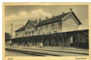
20930. ☒ Pásztó, vasútállomás más (kis szakadások T32200
