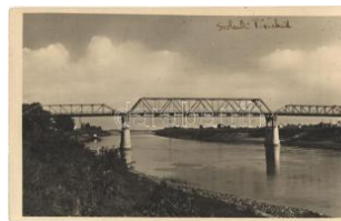
21142. * Szolnok, Tisza-híd T2/3 T2/3 1400
