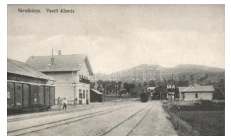
21287. * Abrudbánya, Abru- d; Vasútállomás, R T2 11000
