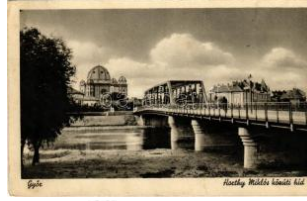
20590. ☒ 1941 Győr, Horthy Miklós közüti híd T2/3 3200
