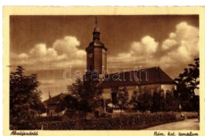
20100. ** Abaújszántó, Római katolikus templó T2 1000
