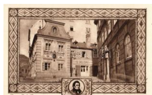
22722. * Wien, Vienna, Bécs; Molkereibastei, Drehturm T4 1000
