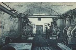
21209. ☒ 1918 Tatabánya, Szivattyú kamra a T2/3 6000
