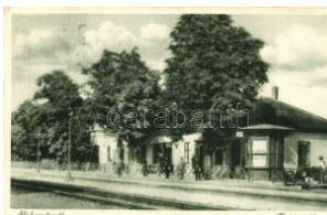
20715. ☒ Hidasnémeti, Vasútállomás, vasutas T2/3 2400
