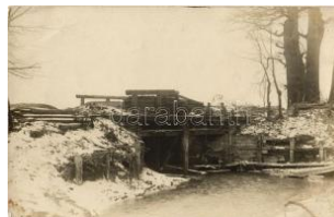
22644. * A felrobbantott lkv a hid provizórikus T2/3 1200
