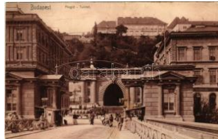
20315. 1905 Budapest I. Alagút (szakadás) / t T3 1000
