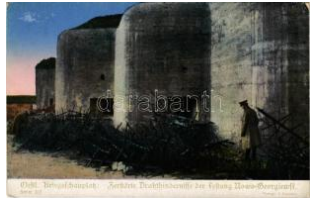
22699. ** Zerstörte Draht Hindernisse der Fe T2/3 1000
