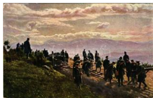
22691. ** Bau einer Feldbahn auf dem russis T2/31000
