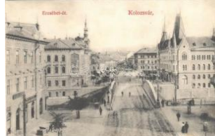
21336. ☒ 1909 Kolozsvár, Cluj; Erzsébet út, híd T22400
