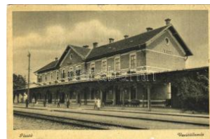
20913. ☒ Pásztó, vasútállomás (kis szakadások T32200
