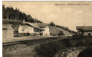
22176. *** Mönichkirchen, Bahnstation / railwa T2 4000
