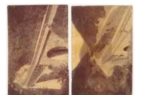
21953. ** Tiszolc, Tisovec; vasúti híd / railway bri 3200
