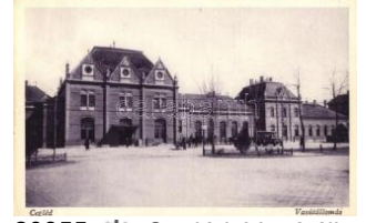
20855. ✳ Cegléd, Vasútállomás (Rb) T2/3 T2/3 1800
