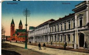
21165. ✱✱ Nyíregyháza, tö rvényszék. Vasúti leve T3800
