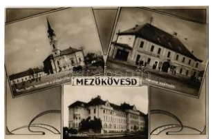
21129. ☒ 1931 Mezőkövesd, Római katolikus templom T22200
