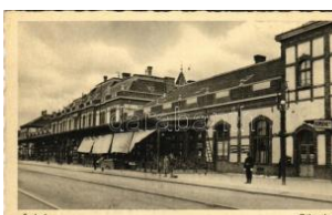
21308. * Szolnok, pályaudvar, vasútállomás, kim T2 2400
