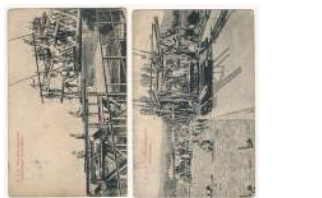
22745. * Cs. és kir. vasúti ezred hidépítés közben 6000
