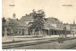
20854. ✳ Cegléd, vasútállomás (Rb) T2/3 T2/3 2400
