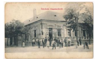
21979. * 1909 Csantavér, Csantavér; Csantavéri K T49000
