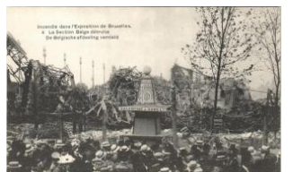
22143. ** Bruxelles, Brussels; Incendie dans l T1 1200
