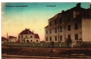
21988. ☒ Cservenka, Crvenka; Cukorgyár. Sc T2/32400
