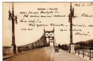
21303. * 1917 Szolnok, Tisza híd. Faragó Sándor T3 1600
