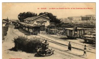
22405. ** Dakar, Le depot du Chemin de Fer e T13000
