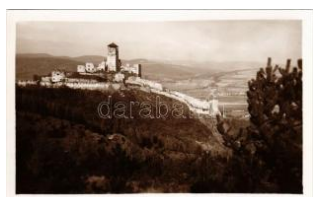
21853. * Trencsén, Trencín; vár / Trenciansky T1/2 1600
