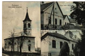
20599. 1931 Felcsút, Római katolikus temp T2/3 3800
