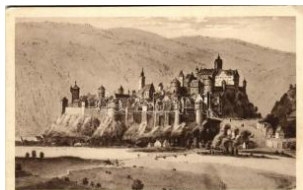
22499. ** Loket, Elbogen; Elbogen im 14. Ja T2/3 1200
