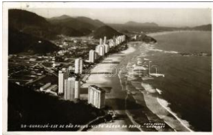
22425. 1962 Guarujá, Vista Aerea da Praia T2/3 1000
