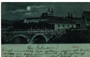
21474. ☒ 1901 Illava, Illau, illava; híd este. Ga T2/37000
