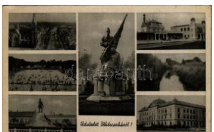
20257. 1944 Békéscsaba, Vasútállomás, Hőső T3 1000
