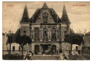
21507. * Kassa, Kosice; Vasúti indóház, vasút T3 3000
