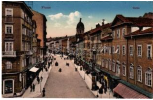
21945. ** Fiume, Rijeka; Corso / street view, sh T22400
