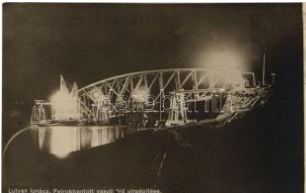
23517. ** Felrobbantott va sűti híd újraépítése, T2 3200
