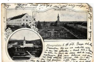
21787. 1902 Ujgradiska, Nova Gradiska; Trg T4 2200
