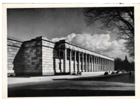
23828. * Bauten des Dritten Reiches! Haus der T3 1600
