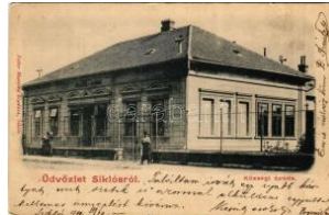
20893. 1903 Siklós, Közsegi óvoda. Feiler M T22400
