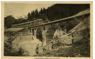
22123. * 1919 Lermoos, Lichtenberg-Viadukt T2/3 2000
