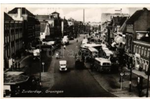
22575. 1949 Groningen, Zuiderdiep / street v T21000
