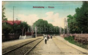
20244. [ ] 1911 Balatonberény, vasútállomás (E T2/3) 3000
