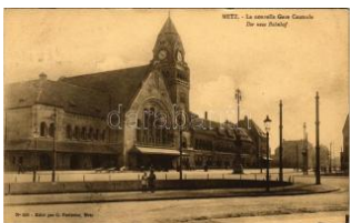
22543. Metz, La nouvelle Gare Centrale / D T2/3 1000
