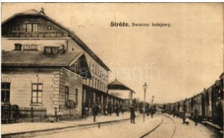
22627. * Stróże, Dworzec kolejowy / railway stat T2 2600
