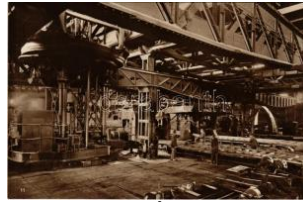
20841. ** Ózd, Rimamurányi-Salgótarjáni vasút T2/32200
