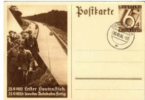
23821. * 1933 Erster Spatenstich - 1936 1000 T2/3 3200
