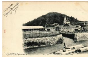
21609. * Zólyombrézó, Pod brezová; Tutajosok T2/35500
