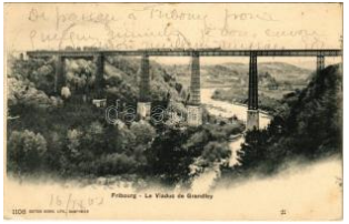
22919. 1903 Fribourg, Le Viaduc de Grandfer T2/3 1600
