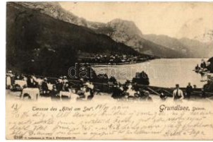
22085. 1905 Grundlsee, Terasse des "Hote T2/3 1000
