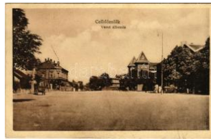
20521. ✱ Celldömölk, vasút állomás, autó. Meste T32400
