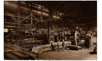
20842. ** Ózd, Rimamurányi-Salgótarjáni vasút T12200
