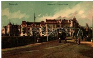
21284. Temesvár, Timisoara; Hunyadi híd T1/25500
