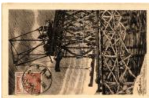
23535. ☒ Montieren der Kriegsbrücke über die T2/3 3200
