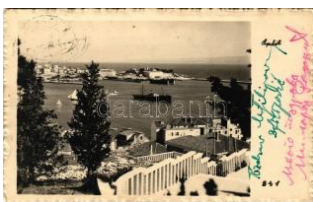
21779. 1939 Split, Spalato; (kis szakadás / T2/3 1000
