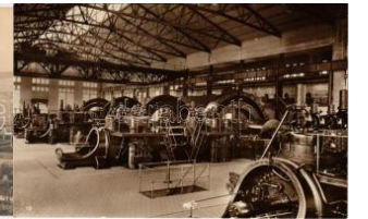
20838. ** Ózd, Rimamurányi-Salgótarjáni vasút T2/3 2600
