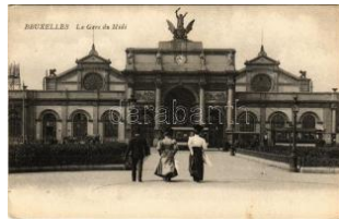
22273. ** Bruxelles, Brussels; La Gare du M T2/31400
