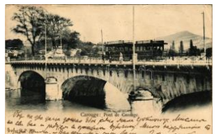
22544. ☒ 1905 Carouge, Pont de Carouge / b T2/3 3600
