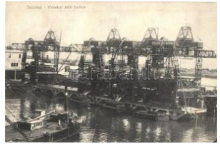
22495. ** Savona, Elevatori delle funivie / elev T21800
