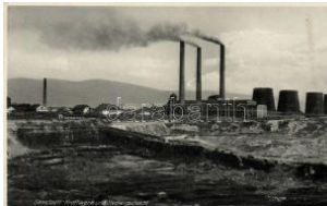
22098. ** Ervenice, Seestadt; Kraftwerk und H T3000
