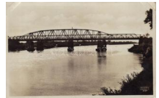
20760. Makó, vasúti híd (EK) T2/3 T2/3 1800
