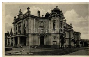
22118. 1931 Ostrava, Moravská Ostrava; Ná T2/32400
