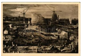
23238. Großkraftwerk im Bau. München, T2/3 1600
