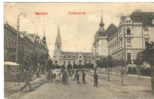
20694. ☒ 1911 Kaposvár, S zéchenyi tér, temp T2/3 1600
