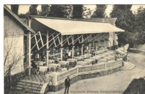
20199. ✱ 1930 Balatonalmádi, Pannónia étterem T23800
