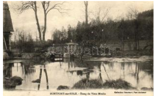
22209. ✨ ✨ Montfort-sur-Risle, Vieux Moulin / old T2 1000
