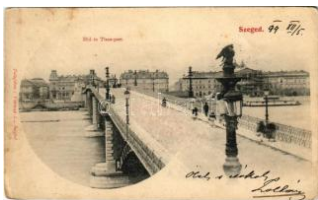
20973. * 1899 (Vorläufer) Szeged, Híd és Tisza- T31600
