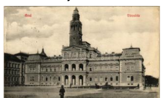
21132. ☒ 1908 Arad, Városház / town hall T2 T2 1800
