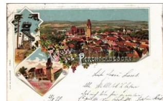
21964. ☒ 1899 (Vorläufer) Perchtoldsdorf, Jos T2/3 5000
