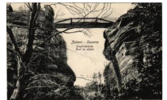
22102. * Saverne, Zabern; Teufelsbrücke / Pont T2/3 1000
