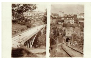
21302. * Tornó, Tarnova, Tarnova; viadukt, alagú T2 22000
