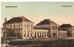
21266. ✳ Szatmárnémeti, S atu Mare; vasútállom T23000
