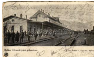
21421. 1904 Ruttká, Vrútky; vasútállom., T3/4 7000
