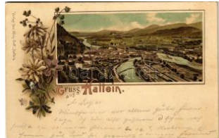
21776. 1897 (Vorläufer) Hallein, general view T35000
