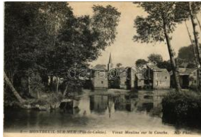
22065. 1913 Montreuil, Vieux Moulins sur la T2/3 1600
