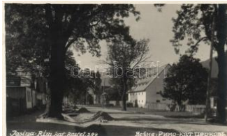
21478. *** Kőrösmező, Jasina; Rím. kat. kostel, T2 2000
