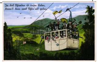
22374. ** Schauinsland, Schwebebahn a. d. T2/3 1000
