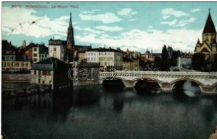
22059. Metz, Mittelbrücke / Le Moyen Pont / T2/3 1000
