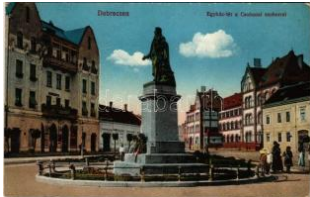
20586. 1915 Debrecen, E. gyház tér, Csokona T2/32400
