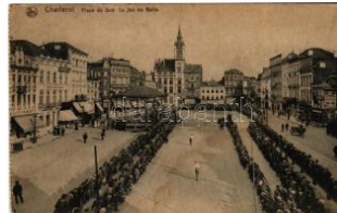
21936. 1918 Charleroi, Place du Sud, Le Je T2/3 1600
