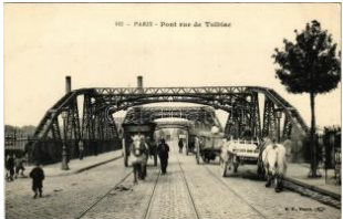
22095. * Paris, Pont rue de Tolbiac / bridge, hor T2 1000
