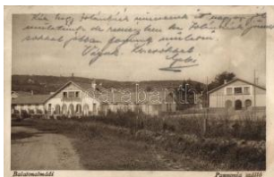
20163. ☒ Balatonalmádi, Pannónia szálló (EK T2/3 1400)
