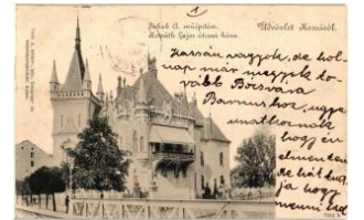
21686. ☒ Kassa, Kosice; Ja kab A. műépítész K T2/32800
