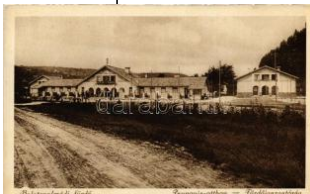
20193. ** Balatonalmádi i-fürdő, Pannonia ott T2 1600
