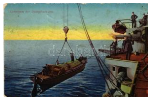
23006. * 1914 Einsetzen der Dampfbarkasse T2/3 3400
