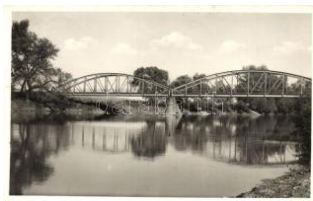
21331. 1911 Dés, Dej; Szamos híd / bridge T2 T2 1200
