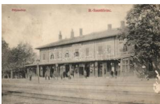
21087. * Szentlőrinc vasútállomás (kis szakad T3/4 1600
