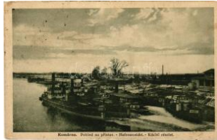
21721. * Komárom, Komárom; Kikötő, "DEVIN T2/31800
