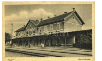
20870. ☒ Pásztó, vasútállomás (kis szakadások) T3 2200
