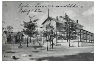
20583. * Dobogókő (Pilisszentkereszt), Bárány Eö T2/3 3000
