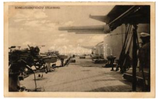
23065. ** Schnellfeuergeschütz Steuerbord K.u T13400
