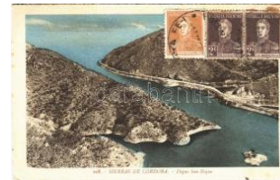
22483. 1930 Cordoba, Dique San Roque. T T2/3 1000
