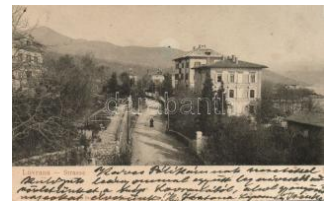
22295. ** Lovran Lovrana; villák / villas (pinhole) T 800
