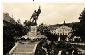
20705. ** Kalocsa, Hősök szobra, Érseki pa T1/21200
