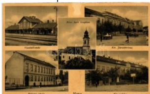
20833. ☒ Monor, vasútállomás, polgári iskola T2/3 1000
