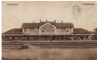
20647. ☒ Gyékényes vasútállomás (EB) T3 T3 800
