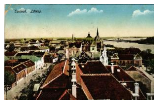
21133. 1916 Szolnok, zsinagó (szakadás / T3 1000
