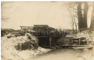
22793. * A felrobbantott lkv a híd provizórius T2/3 1000
