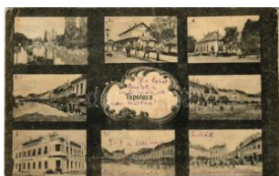
21160. ☒ 1922 Tapolca, mozaiklap vasútállom T2/32200
