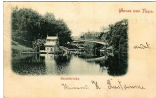
22429. 1899 (Vorläufer) Riga, Basteibrücke T2/31000
