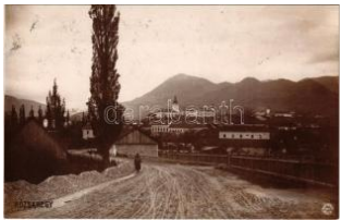
21879. ✖✖ Rózsashegy, Ru zomberok; út, híd / T1/2 7000
