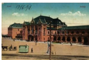
21249. 1918 Arad, indóház, vasútállomás. K T2/31600
