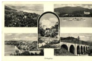
21233. Zebegegény, látkép, viadukt, vasúti híd T2/31000
