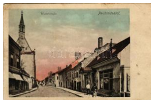
22220. ☒ 1917 Perchtoldsdorf, Wienerstraße / T2/3 2000
