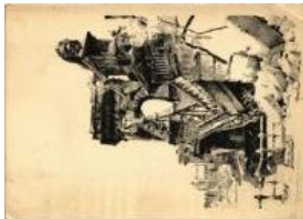
20373. ** Budapest, felrobbantott Lánchíd. M T2/3 1000
