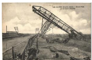
22155. ☒ La Fère, dévastée (Aisne), Grue et T2/3 2000
