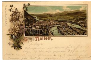
21784. 1897 (Vorläufer!) Hallein, general view T3000
