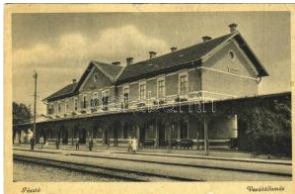
20598. ☒ Pásztó, vasútállomás (kis szakadások T32200
