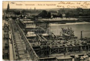
22341. 1909 Dresden, Interimsbrücke, Neu T2/3 1600
