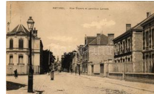
22205. * Rethel, Rue Thiers et pavillon Levert T2/31000
