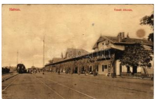
20422. ☒ 1912 Hatvan, vasútállomás, vonat (f T2/3 1000
