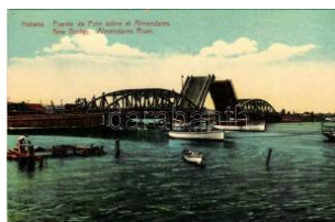
22255. Havana, Habana; Puente de Pote so T11600
