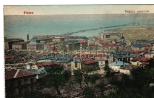
21380. ☒ 1911 Fiume, Rijeka; Veduta genera T2/3 1000
