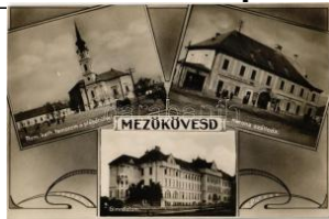
20531. ☒ 1931 Mezőkövesd, Római katolikus templom T22000
