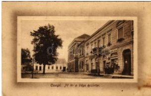
20331. ✳✳ Csurgó (Somog y), Fő tér a Vágó épü T34800
