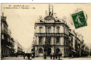
22043. 1917 Saumur, Le Bureau de Postes T2/3 1000
