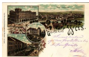
21972. ✉ 1898 (Vorläufer) Wels. Postgebäude T2/3 5000
