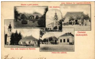
20416. 1909 Csokonya, Csokonyavisonta; T2/3 7000
