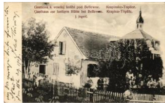
21789. ☒ 1917 Krapinske Toplice, Krapina-Tò T2/3 3400
