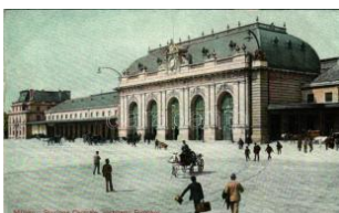
22106. ** Milano, Milan; Stazione Centrale, a T1/2 1000
