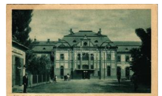
22126. 1919 Csap, Cop, Chop; Vasútállomás. A. T2/3 2400
