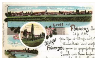
21329. 1900 Fogaras, Fa garas; Totalansicht, T4 9000
