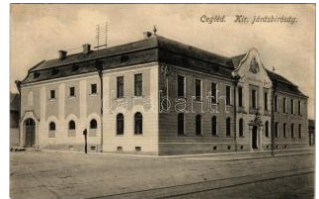
20478. ☒ 1913 Cegléd, Kir . Járásbíróság, villam T24400
