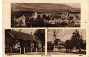
20229. 1936 Bódvaszilás, látkép, vasútállom T3/44400
