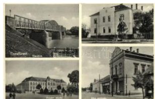
21044. ☒ 1936 Tiszafüred, Tisza-híd, Főszolga T2 1800
