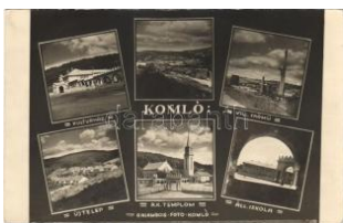
20715. ☒ Komló, Kultúrház, Villamos erőmű, Ú T2/31600
