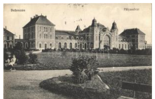
20492. ☒ 1913 Debrecen, P ályaudvar, vasútállom T2800
