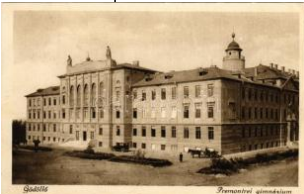
20599. ☒ 1926 Gödöllő, P remontrei gimnázium T21800
