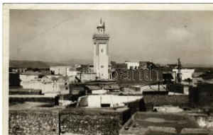
22596. * Oujda, Vue générale et la Mosquée / T3 1000
