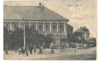
20750. * 1907 Makó, utcák építési munkála T33000
