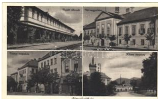
20899. * 1937 Sátoraljaújhely, Vasútállomás, T2/3 1800
