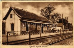
20603. ✳ Gyömrő, Gyömrő -Tófürdő vasútállom T3/4000
