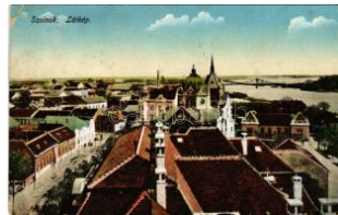
20870. ✉ 1916 Szolnok, zsinagóga (szakadás / T3 1000
