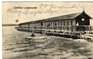
20172. 1907 Balatonalig a (Balatonvilágos), F T4 6000
