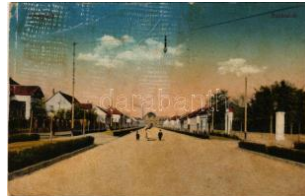
20576. * 1920 Cegléd, Rák óczy út. Vasúti levele T3 2400
