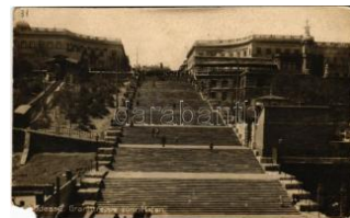
23609. 1918 Odessa, Od esa; Granittreppe zu T4 3000
