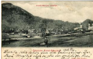
21534. ☒ 1906 Felsőbánya, Felső-Bánya, Baia T3 7000
