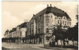
20759. ☒ Kecskemét, Rákóczi út, szecessziós C T2 2000
