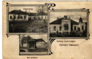
21460. * 1919 Dálnok, Dal nic; állami iskola, Re T3 8000
