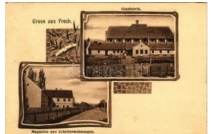
21516. ☒ 1913 Felek, Frecsk, Avrig; Glasfabrik, T2 9000
