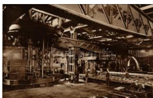
20923. ** Ózd, Rimamurányi-Salgótarjáni vasút T2/32200
