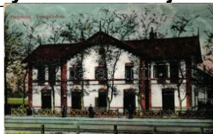
20904. ☒ 1909 Nagykáta, Vasútállomás (EK) T3 T3 5500
