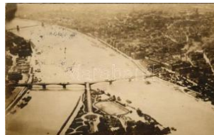
20340. ☒ 1920 Budapest, Margit híd. "Túloldal T2/38000
