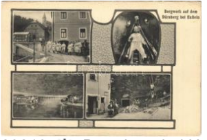
23210. * Dürrnberg bei Hallein, Bergwerk, Be T1/2 1600
