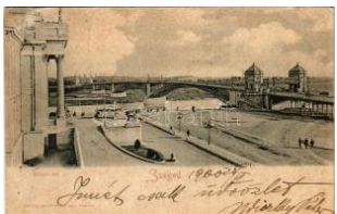
21250. 1900 Szeged, Közüti híd (szakadás / tea T300
