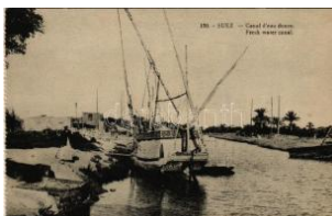
23767. ✳✳ Suez, Canal d'eau douce / Fresh wa T21000
