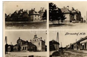
23669. 1937 Strasshof a n der Nordbahn, Alo T2 2000
