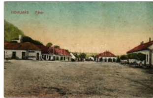
21816. ** Hídalmás, Hida; Fő tér, üzlet / main T2 4600
