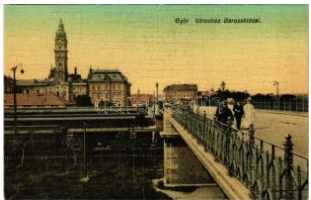
20786. ** Győr, Városház, Baross híd a vasúti T1/2 1200
