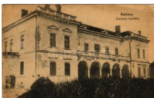
20258. *** Balkány, Gencs y kastély (szakadás T3 2600
