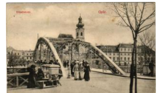
20513. ☒ Győr, Erzsébet tér, híd, hölgyek, pia T2/3 1200
