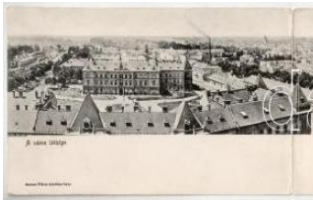
20526. ** Győr, A város látképe építkezéssel T2/3 2000
