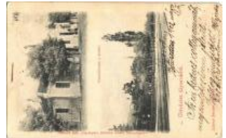
21537. 1902 Győrök, Ghiorok; Vasútállomás T4 6000
