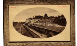
20497. ☒ 1916 Győr, MÁV indóház, vasútállom T2/3 2000
