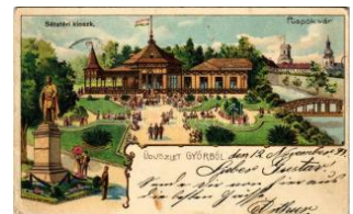
20509. ☒ 1899 (Vorläufer) Győr, Sétatéri kiosk T2/3 1200
