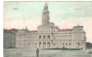
21045. * Arad, Városháza / town hall (gyűrod T2/3 1600
