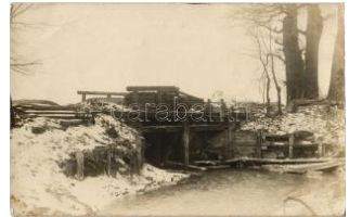
23602. * A felrobbantott Ikv a hid provizórikus T2/3 1000
