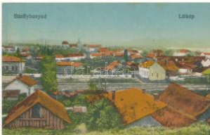
21130. ** Bánffyhyunad, H uedin; vasútállomás T214000
