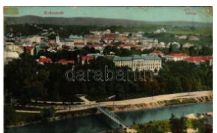
21783. ☒ 1913 Kolozsvár, Cluj; híd / bridge (E T2/3 1400
