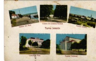
23366. * Turnu Severin, Szörényvár; Vedere d T2/3 2000
