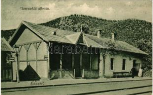
20814. ✱ 1927 Szarvaskő, Vasútállomás (EK) T2/34000
