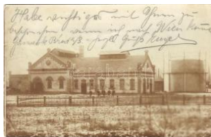
21264. Brád, Gaswerk / Gázgyár télen / ga T2/3 7000
