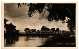
21444. ✱ 1940 Dás, Dej; Sz amos híd / Somes br T21400
