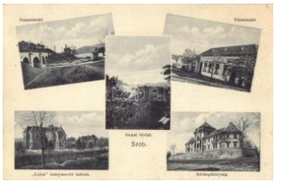
20848. Szob, Dunai távlat, híd, vasútállomás, T22000
