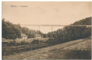
22628. Resica, Resita; Aquadukt, vasúti sín T19000
