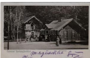
20488. ☒ 1903 Harkányfürdő, gépház. Feiler M T2/32000
