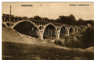
20736. * 1914 Salgótarján, Somlyói vasbeton T2/3 2000
