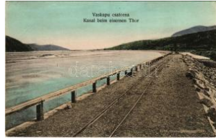
22526. Orsova, Vaskapucsatorna, vasúti sín T24200
