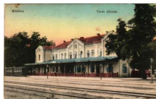
20969. 1912 Alvinc, Vintu de Jos; vasútállomá T3 5500
