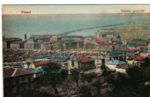
23468. ☒ 1911 Fiume, Rijeka; Veduta genera T2/3 1000
