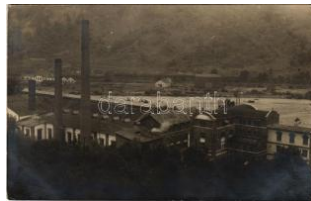
23833. 1931 Campina, U zina Electrica / ele T2/3 4600
