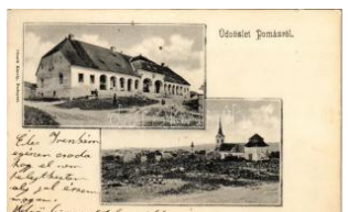
41106. Pomáz, Wattay-Teleki kastély (még) T2/3 1800
