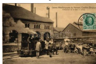
43991. Couillet, Usines Metallurgiques du Ha T2/31000
