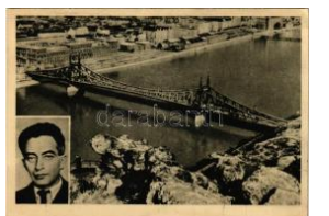
40267. Budapest, A lerombolt híd helyett T2/3 1800
