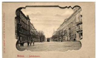
44015. * Brno, Brünn; Ja dokstrasse / street v T2 1600
