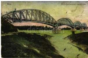
40145. ✨ 1917 Baja, Baja-Bátaszéki vasúti híd T3/4 2000
