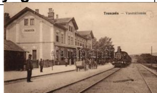
43613. * Trenčín, Trenčín; vasútállomás, gőz T2/33000
