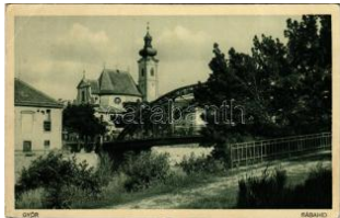
40798. 1934 Győr, Rába híd (EB) T3 T3 1000
