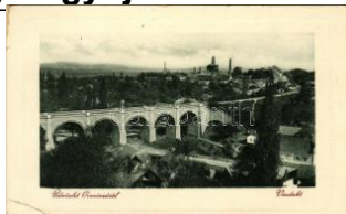
42587. ** Oravica, Oravicza, Oravita; Viadukt, T3 3200
