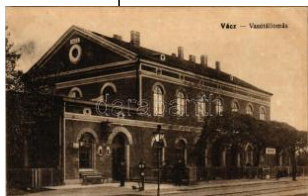
41369. ** Vác, vasútállomás. Vasúti levelező T15500
