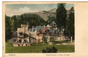
44268. ** Sinaia, Vederea Cantinei si Corpu de T23000
