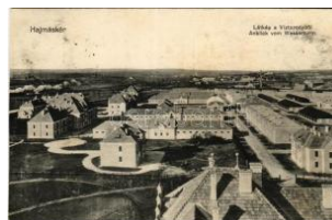
44812. 1917 Hajmáskér, látkép a víztornyóbó T43200
