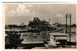
43833. Újvidék, Novi Sad; híd / bridge T 21000
