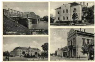
41351. 1936 Tiszafüred, Tisza-híd, Főszolga T2 1800
