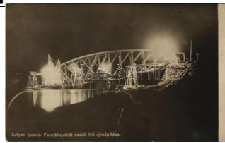
44764. * Felrobbantott vasúti híd újraépítése. L T2 2000
