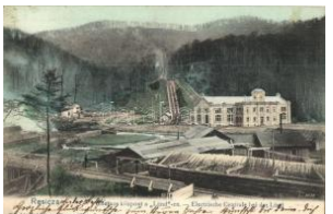
42685. 1905 Resica, Resita; Villamos központ T2/35000
