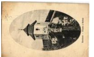
43300. ☒ 1912 Komárom, Komárom; kőszűz a T2/3 1000
