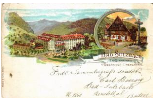
43935. * 1900 Bad Sulzbach (Lautenbach), spa. T31200
