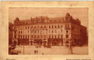
40481. ** Budapest V. Eta blissement Gerbeau T3 3600
