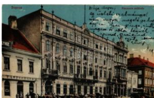
41373. ☒ 1936 Sopron, Pannonia szálloda, kávéház T2 2400
