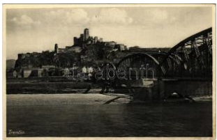
43483. Trencsén, Trencin; vár, híd. E. Sevc T2 1000
