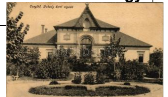
40716. ✱ Cegléd, Gubody kert, vigadó. Vasúti le T2 2000
