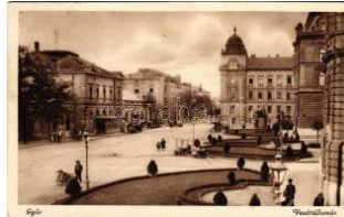
40878. ☒ 1935 Győr, Vasúttállomás (EK) T2/3 T2/3 1000
