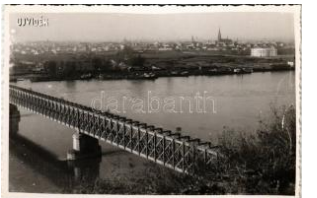
43683. 1944 Újvidék, Novi Sad; Vasúti híd / T1/2 1800
