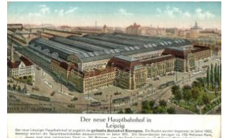
44602. ✳✳ Leipzig, Der ne ue Hauptbahnhof, gr T2 3600
