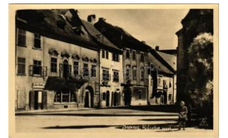
41404. ** Sopron, Kolosto r utca, Kerni Márton T1 2600
