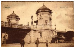
41421. 1920 Szeged, Közúti híd, Vasúti lev T2/3 1000
