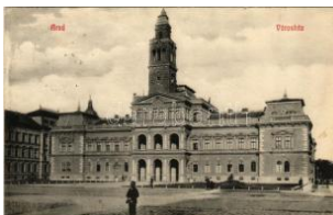
41697. ☒ 1908 Arad, Városház / town hall T2 T2 1400
