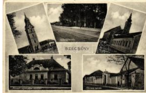
40958. 1936 Szécsény, vasútállomás, őrtoro T2/31000
