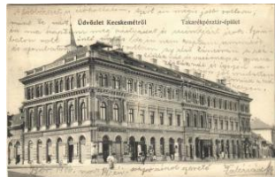
40625. ☒ 1906 Kecskemét, Takarékpénztár épü T3000
