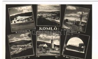
40665. ✉ Komló, Kultúrház, Villamos erőmű, ú T2/31600
