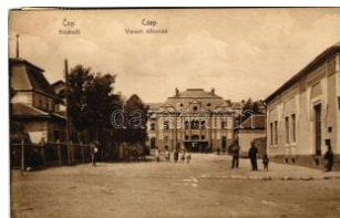
41538. * Csap, Chop, Čop; vasútállomás / Na T2/34000
