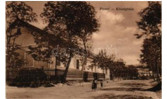
41374. ✳✳ Pécel, Községháza. Vasúti Levele T2/3 2600
