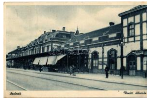
41653. Szolnok, Vasútállomás (szakadás / T3/4 1000
