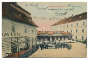
42459. 1911 Stubnyafürdő, Túróchéviz, St T2/3 22000
