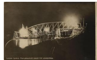
43658. * Felrobbantott vasúti híd újjraépítése. L T2 1600
