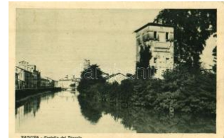
43258. ** Padova, Castel lo del Diavolo / tower T 2100
