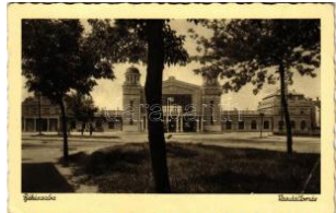
40344. ✱ 1938 Békéscsaba, vasútállomás (EB) T3 1000
