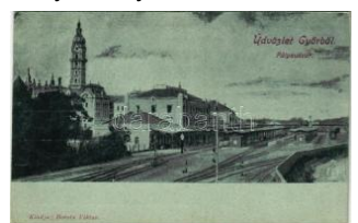
40942. Győr, pályaudvar, vasútállomás e T1/2 7500
