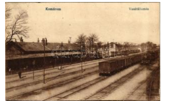
42142. 1932 Komárom, Komárnó; vasútállom T2/34000
