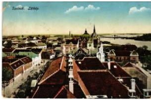
41651. 1916 Szolnok, zsinagóga (szakadás / T3 1000
