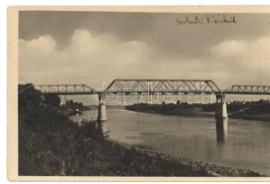
41665. * Szolnok, Tisza-híd T2/3 T2/3 1400
