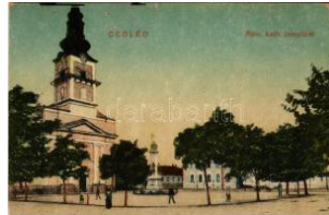
40729. 1922 Cegléd, Római katolikus templom T4 1000
