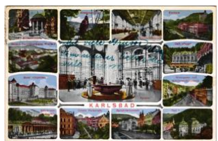
43052. ☒ 1926 Karlovy Var y, Karlsbad; Kurhaus T3 1000
