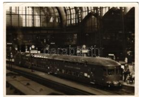
43932. ☒ 1937 Hamburg, Hauptbahnhof, Doppelgleis T2/3 2000
