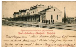
41524. ☒ 1899 (Vorläufer) Sopron, Győr-Sopron T2/3 7000
