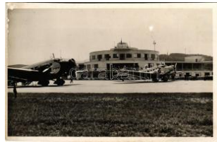
40397. ✱ Budaörs, a repülőtér állomás épülete T2/33200
