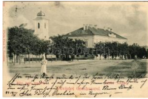
41105. ✉ 1899 (Vorläufer) Orosháza, Római ka T2 9500
