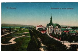
43152. ** Turnu Severin, Szörényvár; Bulevar T2 5500
