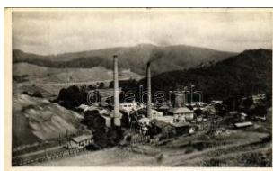
41189. ** Salgótarján, Vízválasztó villanytele T2/31800
