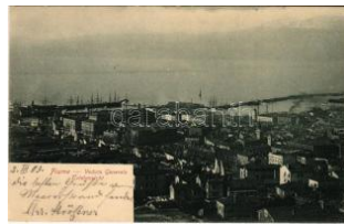
42608. 1903 Fiume, Rijeka; Veduta generale T2 1000
