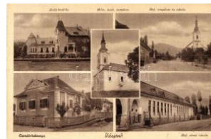
40718. ☒ Diósjenő, Római katolikus templom, re T2 1600
