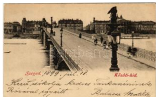
41259. 1899 (Vorläufer) Szeged, Közúti híd T2/33500
