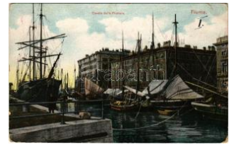
42614. Fiume, Rijeka; Canale della Fiumara / T3 1000
