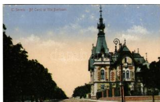
43151. ** Turnu Severin, Szörényvár; Bulevar T2 5500
