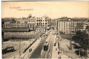
42715. ** Bilbao, Puente de Isabel II / bridge T2/3 1000
