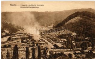
41388. ** Resica, Resita; Industria destillerei T1 5500
