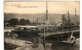
42714. ** Bilbao, Diques Secos Euskalduna T2/3 1000
