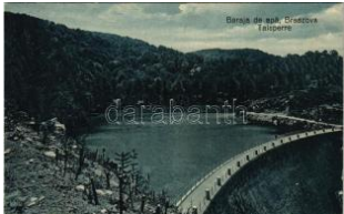
40945. ** Brázova, Breazova; Völgyzáró gát. B T15500
