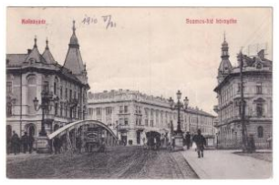
41206. 1910 Kolozsvar, Cluj; Szamos híd k T2/3 2600
