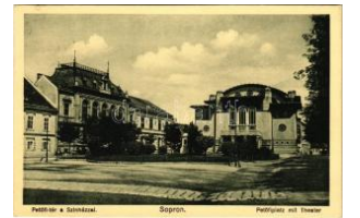
40951. 1931 Sopron, Petőfi tér a színházzal. T22000
