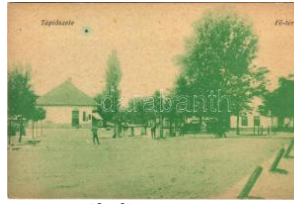
41062. Tápiószéle, Főtér, üzlet. Hangya sz T2 1600
