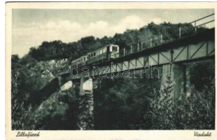
40745. 1939 Lillafüred, vasúti híd, v T2/31600
