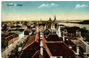
41033. 1916 Szolnok, zsinagóga (szakadás / T3 1000
