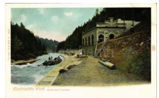
42651. Roitham am Traunfall, Elektrizitätsw T2/31200
