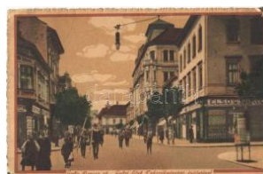
40586. Győr, Baross út, Győri Első Takarékszövetkezet T2/32000
