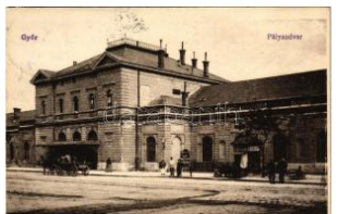
40580. 1920 Győr, pálya udvar, vasútállomá T2/31400
