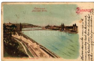
40228. 1904 Budapest, Eszaki téri híd (Erzsébet T2/3 1000
