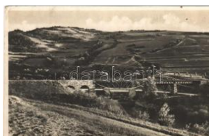
42298. ☒ 1943 Kárpátalja, viadukt, vasúti híd T2/3 1600
