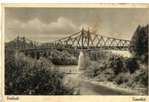
41030. Szolnok, Tisza híd (EK) T2/3 T2/3 1000
