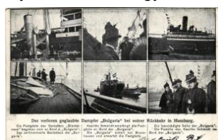
43262. ☐ 1899 (Vorläufer) Der verloren gegla T2/3 1600
