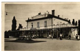
40140. ✉ Balatonföldvár, v asútállomás T2 T2 1600
