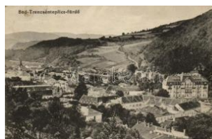
42203. Trencséntepec-fürdő, Kupele Trenci T21400
