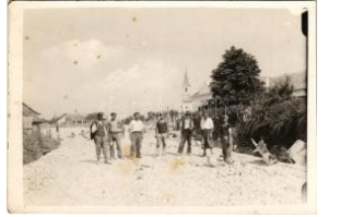
40888. * Gyenesdiás, útépítő munkások, Tóp T3/4 5000
