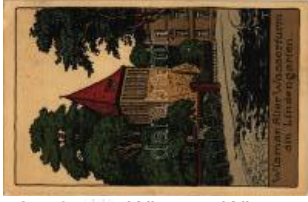
42559. 1903 Wismer; Alter Wasserturm T2/3 1200
