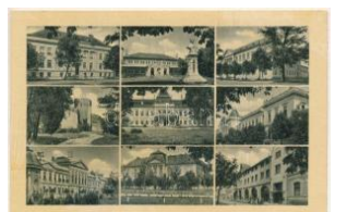
40922. ** Gyula (ázott / wet damage) T3/4 T3/4 1000
