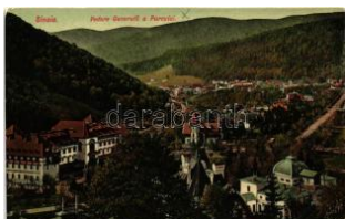
42414. ☒ Sinaia, Vedere g enerala a parcului T2/3 1000
