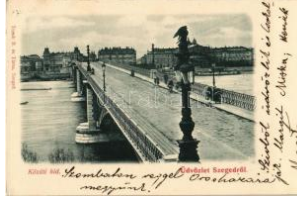
40796. 1899 Szeged, Kö zúti híd, építkezés. T2/32200
