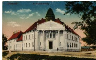
40375. * 1927 Dombóvár, M. kir. járásbíróház. T2 1600
