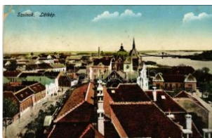
40830. 1916 Szolnok, zsinagóga (szakadás / T3 1000
