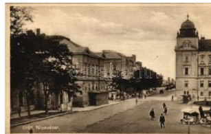
40476. ✉ 1931 Győr, pálya udvar, vasútállomá T2/3 1600
