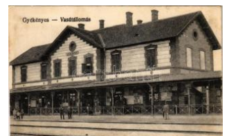
40457. ** Gyékényes, Va sútállomás. Vasúti T2/3 3000
