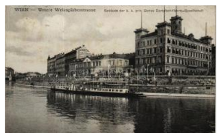
42281. 1909 Wien, Vienna, Bécs; Gebäude T2/3 1600
