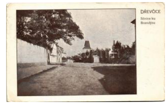
42313. 1917 Dřevčice, Silnice ku Brandysu T2/3 1400
