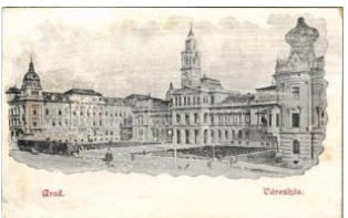
40947. ✳✳ Arad, Városháza, városi vasút, vona T43200
