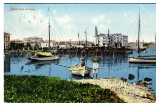
41878. 1909 Zada, Zadar; Vale di bora / por T2/3 3800
