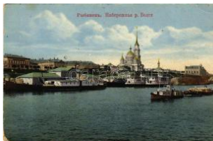
42053. * Rybinsk, Volga riv er embankment (E T2/3 1200
