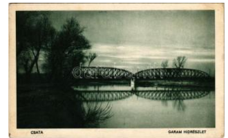
41563. ☒ 1940 Csata, Cata ; Garam vasúti híd T2/3 5500
