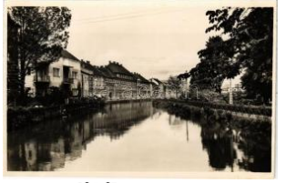
41608. ** Kassa, Kosice; Malom árok / mill dít T22000
