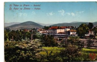
42224. 1913 Pivka, St. Petera na Krasu, San T2/31600
