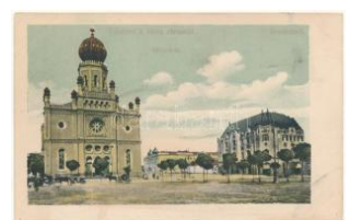
40499. ✱ Kecskemét, Rákóczi út, zsinagóga. T2/3 10000
