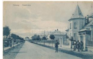
41030. ✱✱ Hátszeg, Hátszeg; Vasút utca, vasút T2/3 9000
