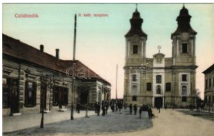
40392. ** Celldömölk, Római katolikus templom T2 16000
