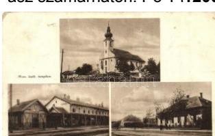
40476. ✱ Kál-Kápolna, vasútállomás, pénzügyorsé T3800
