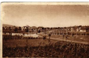
40216. Balatonfüzfő, Villa csoport (ázott / wet T3) 1800
