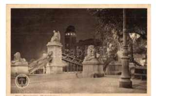
43164. ☒ Vienna, Wien; A spernbrücke / bridge a T2 1000
