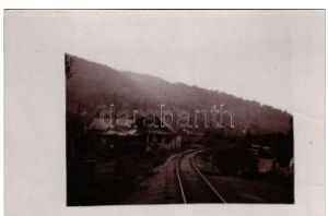
42389. * Zalatna, Zlatna; vasút vonal Abruđbány T36000
