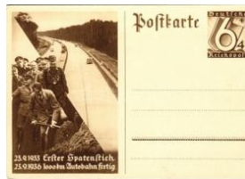
44591. ** 1933 Erster Spatenstich - 1936 100 T2/3 2400
