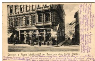
40473. 1903 Budapest V. Fiume kávéház a M T25000
