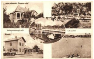
40233. Balatonmáriafürdő, Csatorna-híd, va T2/3 1600
