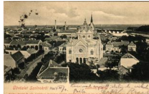
41430. 1904 Szolnok, lát kép a zsinagógáva T2/3 7500
