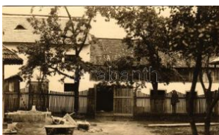
41744. * Felsőbánya, Baia Sprie; A volt Hoffer T1 6000
