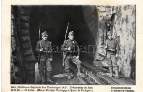
44261. ** Tunnelbewachung in Österreich-U T2/3 3600
