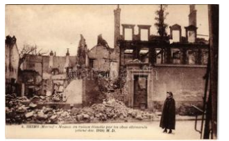
44338. ** Reims, Maison en ruines démolie T2/3 1000
