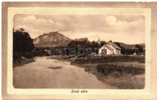
41344. Sirok vár (ázott / wet damage) T3 T3 1400
