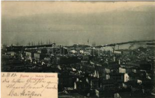
42752. ☒ 1903 Fiume, Rijeka; Veduta generale T2 1000
