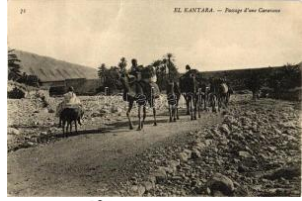
42983. * El Kantara, Passage d'une Caravane / T3 1000
