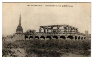
43538. ** Madagascar, Construction d'un pala T13000
