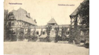
40183. Balatonföldvár, Arabonczias szálló T2/3 2000
