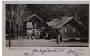
41014. 1903 Harkányfürdő, gépház. Feiler M T2/31600
