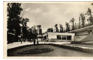
40439. * Budapest II. Úttör ővasút, Hűvösvölgy T2/3 1400
