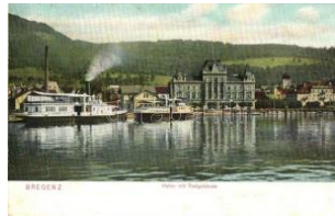
43043. ** Bregenz, Hafen mit Postgebäude / p T2 1200
