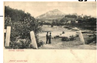
41343. Sirok, várom (ázott / wet damage) T3 T3800
