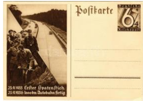
44586. ** 1933 Erster Spatenstich - 1936 100 T2/3 2000
