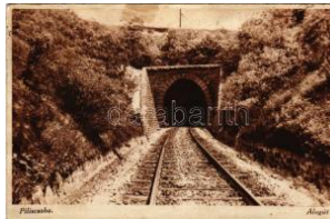
41282. * 1933 Piliscsaba, Vasúti alagút (fl) T2/ T2/3 2400
