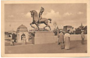
42547. 1913 Leipzig, Internat. Bauausstellung T2/3 2000
