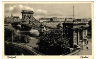
40260. Budapest, Lánc híd, budai hídfő (EK) T2/31000
