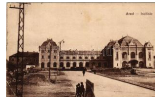
41010. ☒ 1918 Arad, Indóház, építkezés, vasú T2/35500
