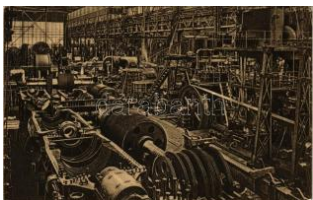
42499. ✱ Essen, Aus Krupp's Fabrik, Reparatur- T2 2000
