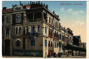
42224. ☒ 1915 Ostrava, Moravská Ostrava, M T2/3 2400
