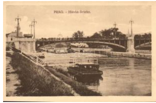
42232. ✳✳ Praha, Prague; Hlavka-Brücke / Hlav T2/3 1400
