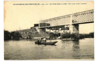
42294. ☒ 1907 Les Ponts-de-Cé, Catastrophe T2/3 5000
