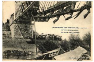
42293. ☒ 1907 Les Ponts-de-Cé, Catastrophe T2/3 7000
