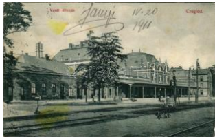
40464. 1911 Cegléd, Vasútállomás, létra. Ste T32400
