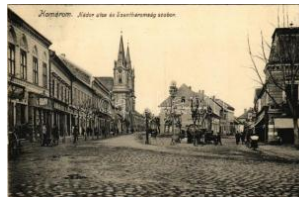
41717. ☒ Komárom, Komárom; Nádor utca, S T2/3 3200
