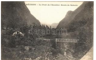
42660. ** Le pont de l'Escalier (Route de Salaz T13000
