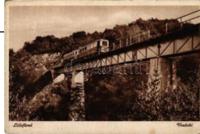
40697. ** Lillafüred (Miskolc), viadukt, Vasúti T3 1600
