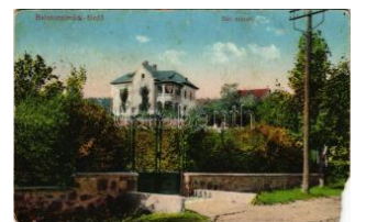
40207. * 1924 Balatonalmádi, Sáry nyaraló, villa T4 1400
