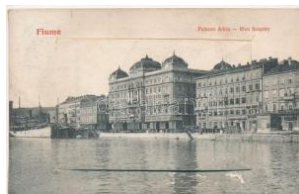
42045. * 1909 Fiume, Rijeka; Palazzo Adria, Riv T3 2400
