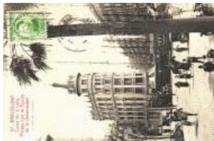
42693. ☒ Barcelona, Cruce de la calle Pelayo T2/3 1000
