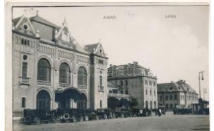
40949. ☒ 1931 Arad, Gara / vasútállomás, autó T3 24000
