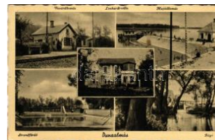
40579. ☒ 1941 Dunaalmás, hajóállomás, vasút T21200
