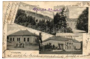
40186. ☒ 1905 Alcsút, Főhercegi kastély, udvar T39000
