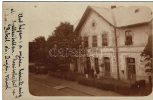
40710. * Mezőcsát, vasútállomás. photo (sza T3/4 7000
