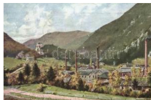
42286. * Waldegg, Metallw arenfabrik / steel fac T4 1000
