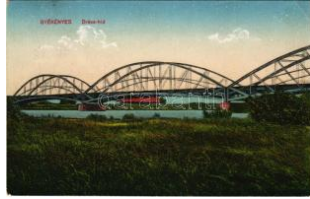
40617. 1919 Gyékényesi, Dráva vasúti híd. T2/3 1000
