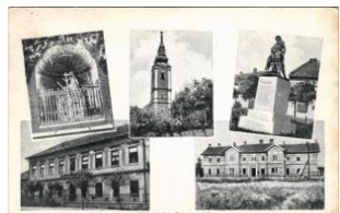
40774. ☒ 1949 Pásztó, tem plom, vasútállomás T2/31200
