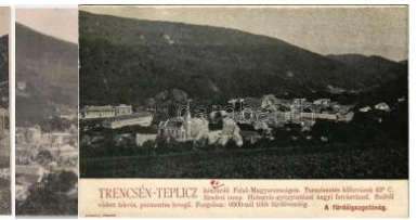
41780. 1901 Trencsén-teplíc, Trencianske T2/3 35500
