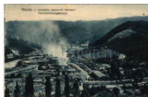
41386. ** Resica, Resita; Industria destillerei T34000
