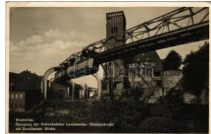
42239. 1937 Wuppertal, Übergang der Sch T2/3 2000
