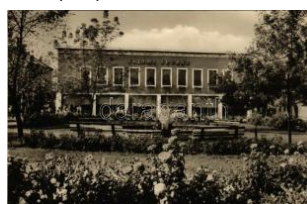
40814. ☒ Salgótarján, Állami áruház, park. Képző T3/1000
