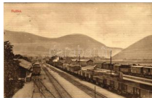
41730. 1914 Ruttká, Vrut ky; vasútállomás, vo T29000
