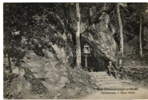
41782. 1916 Trencsén-teplíc, Trencianske T2/3 33000
