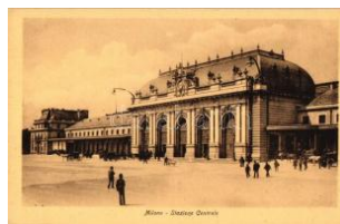
42340. ✱✱ Milano, Stazione e Centrale / railway s T11600
