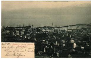
41870. 1903 Fiume, Rijeka; Veduta generale T2 1000
