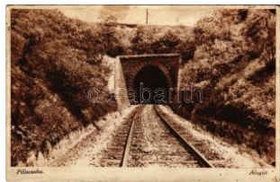
40789. ✱ 1933 Piliscsaba, Vasúti alagút (fl) T2/ T2/3 1800
