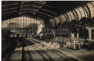
42139. Hamburg, Hauptbahnhof, Innenansicht T23200
