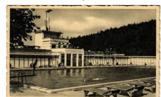
40847. ** Sopron, Lővér u- szoda, fürdő (EK T2/3700)
