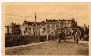
41489. ** Temesvár, Timisoara; Hunyadi híd, T24800
