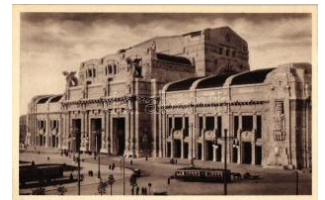
42337. ✱✱ Milano, 'Stazione e Centrale' / centra T2/31200
