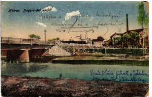
40600. 1921 Hatvan, Zagva híd (kopott sarka T31000
