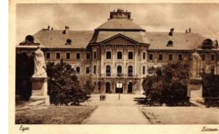
40547. Eger, líceum (ázott / wet damage) T4 T4 9000
