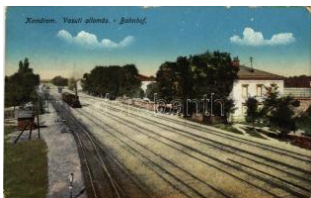
42427. ☒ 1917 Komárom, Komárnó; vasútáll T2/3 3200
