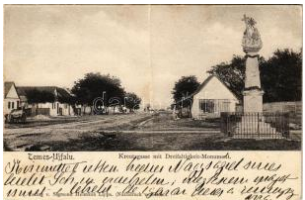
42183. 1907 Temesújfalú, Temes-Ujfalú, Neud T48000
