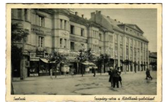
41214. 1943 Szolnok, Szapáry utca, Hítelbáza T2/31600
