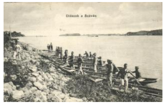
43797. * Utászok a Száván / construction unit T2/3 1600
