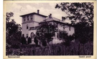
40330. 1929 Balatonalm ádi, Családi penzió T2/3 1200
