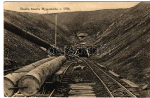
41812. * Miava, Myjava; Stavba tunelu Myjavs T2/39000
