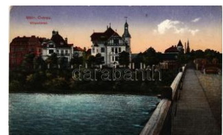
42309. ✱✱ Ostrava, Moravská Ostrava, Mäh T2/3 2400
