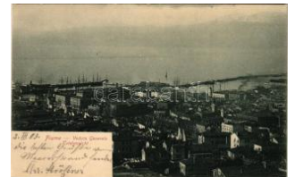
42001. 1903 Fiume, Rijeka; Veduta generale T2 1000
