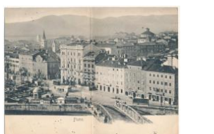
41992. * Fiume, Rijeka; lát kép, hid, villamos. D T3 7000
