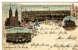
42312. ☒ 1911 Ostrava, Moravská Ostrava, Mäh T3 5000
