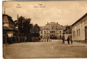
41940. 1942 Csap, Chop, Cop; vasútállomás / Na T2/33000
