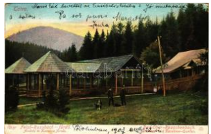
41734. ☒ 1907 Felsőzúg-fürdő, Ruzsbachfű T2/36000
