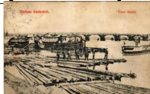
41006. 1910 Szolnok, Tisza részlet, híd, faús T41000
