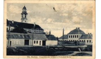
41889. Szakolca, Uhorská Skalica; Frantiskan T34400
