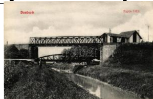
40621. * Dombóvár, Kaposkötő vasúti hídja, kö T 13800
