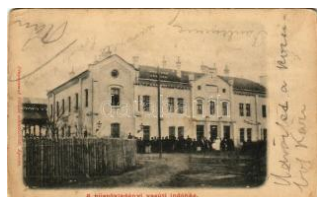
40713. * 1901 Püspökladá ny, vasúti indóház, v T3 2400
