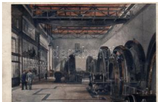
42241. ✱ Gersthofen, Maschinenhalle des Wass T3 1600
