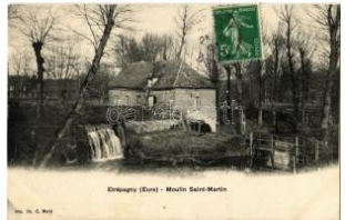
42416. Etrépagny, Moulin Saint-Martin / water T2 1600
