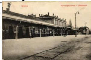
40757. ☒ 1915 Sopron, Déli vasúti pályaudva T2/3 4400
