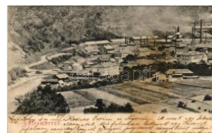
42042. ✳ 1905 Zólyombrezó, Podbrezová; vasgyá T300
