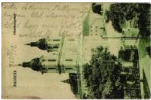
40592. * 1922 Kalocsa, Fő székesegyház, teme T3 1200
