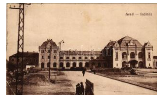
40918. ☒ 1918 Arad, Indóház, építkezés, vasú T2/3 35500
