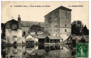
42403. Alençon, Normandie, Pont de Sarthe e T2 1600
