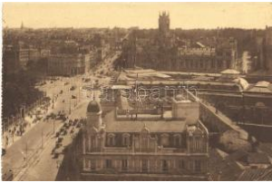
42679. ** Madrid, Vista pa rcial desde el edific T2/32000
