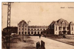
40981. ☒ 1918 Arad, Indóház, építkezés, vasú T2/3 5500
