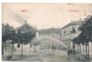
40834. 1908 Sopron, Újtelek utca, üzletek, T3 16000
