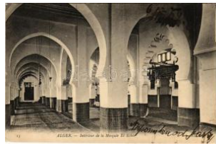
42291. 1907 Algiers, Alger; Interieur de la Mo T21600
