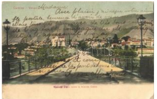
42811. * Caracas, Viaducto Union sobre la Av T2/3 2000
