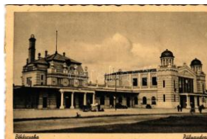
40357. ✳ Békéscsaba, pályaudvar, vasútállom T3/41000
