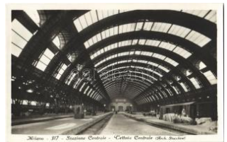
42540. ** Milano, Stazione e Centrale, Tettola T2/3 2000
