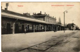
40836. 1915 Sopron, Déli vasúti pályaudva T2/3 4400
