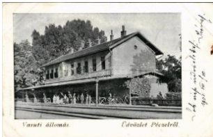
40948. ✉ 1902 Pécel, vasúttállomás (f) T2/3 T2/3 5000
