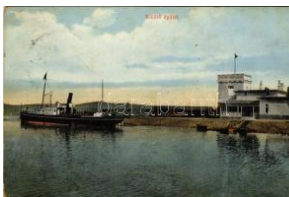
40308. 1914 Balatonboglár, kikötő épület, gó T3 4000
