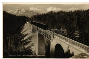
42481. ** Mariazellererbahn, Viadukt über d T2/3 8000
