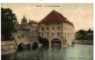
42844. Dole, Le vieux Moulin / old mill (EB) T2 T2 3200
