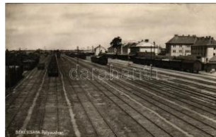
40345. * Békéscsaba, Pályaudvar, vasútállom T2/33000
