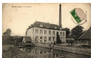
42845. Evry-le-Chatel / mill (EK) T2/3 T2/3 1200
