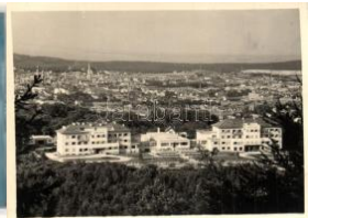
40985. ☒ Sopron, Lövérszálló, foto Diebold-Gru T21000
