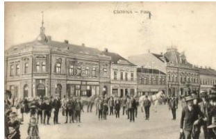
40653. ☒ Csorna, Főtér, Va sudvar, üzletek; kiad T2 3000
