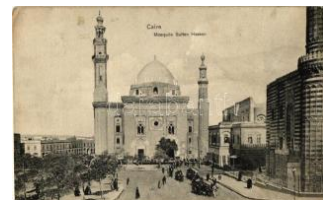
42779. * Cairo, Caire; Mosquée Sultan Hassa T2/31200
