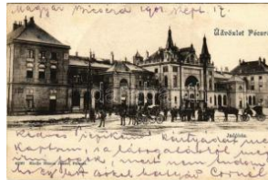
40950. ✉ 1901 Pécs, indóház, vasúttállomás. Bla T2 1800
