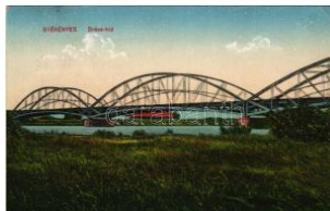
40742. [ ] 1919 Gyékényes, Dráva vasúti híd. T2/3 1000
