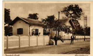
41086. 1927 Zamárdi, vasútállomás (EK) T2 T2/33000
