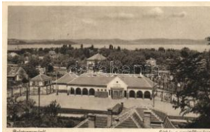
41084. Zamárdi, vasútállomás (EK) T2/3 T2/3 1600
