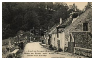
42933. ** Vaux-de-Cernay, Moulin des Roches T2/32000
