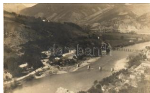
43439. ** Felrobbantott híd közelében épít T2/3 1600
