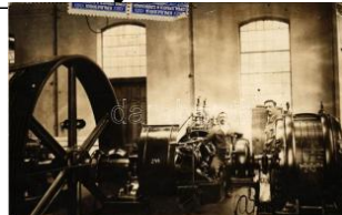
43227. ☒ Erőmű, gépház belseje / power station T2/3 1000
