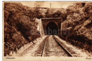
40863. ✱ 1933 Piliscsaba, Vasúti alagút (f) T2/ T2/3 1200
