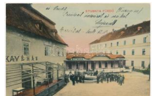
42728. 1911 Stubnyafürdő, Túróchéviz, St T2/3 22000
