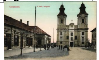
40476. ✱✱ Celldömök, Római katolikus templom T2 16000
