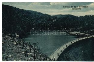
41294. ✱✱ Brázova, Breazova; Völgyzáró gát. B T 1500
