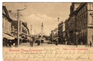
40807. ✉ 1900 Nagykanizsa, a, Fő tér, Felső temp T26500
