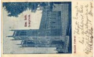
40561. Fót, Római katolikus templom. Első T2/3 6500
