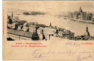
40287. ☒ 1899 (Vorläufer) Budapest I. Kilátás a T41000
