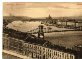
40279. 1911 Budapest I. Lánchíd utca épület T2 3600
