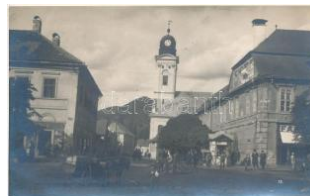
41787. 1928 Nagybánya, Baia Mare; Híd ut T2/33200
