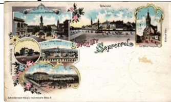
40923. 1898 (Vorläufer) Sopron, Széchenyi s T36000
