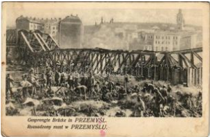
44628. Gesprengte Brücke in Przemysl. Ro T2/32600
