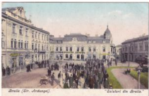
44200. 1910 Braila, Strada Archangel, Casa T212000
