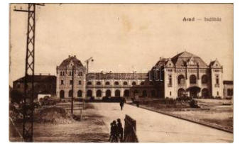
41771. ☒ 1918 Arad, Indóház, építkezés, vasú T2/3500
