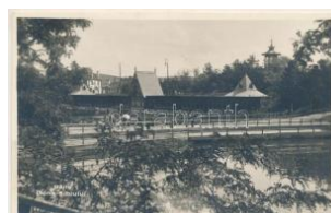
43202. ** Vízakna, Hunedoara; Vízakna-fürdő, Salzbürg, Baile Ocn T2 28000
