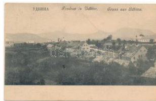
43853. ☒ Udbina, látkép / g eneral view (fl) T2/ T2/3 6000
