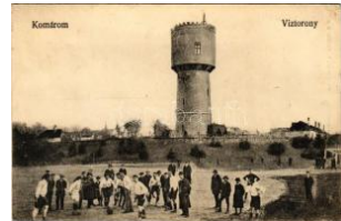
43407. 1919 Komárom, Komárom; víztorony, la T2/3 27000
