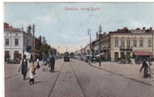
44201. 1924 Braila, Strada Regala / street T2/3 12000
