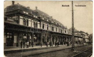
41587. ** Szolnok, vasútállomás. Faragó Sánd T32000
