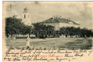
41326. 1899 (Vorläufer) Orosháza, Római ka T2 9500
