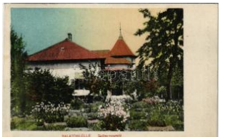
40341. * Balatonlelle, Szűz Mária nyaraló. Vasúti lejárattól T2/3 6500
