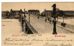
41509. ☒ 1899 (Vorläufer) Szeged, Közúti híd T2/35500
