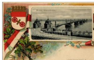
44131. ✳✳ Mainz, Strassenbrücke / bridge. L. K T4 2600
