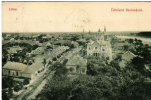
41584. 1908 Szolnok, lát kép a zsinagógáva T2/34200
