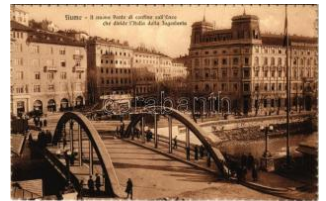
43819. ** Fiume, Rijeka; I l nuovo Ponte di con T2 2400
