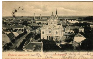
41578. 1904 Szolnok, lát kép a zsinagógáva T2/37500
