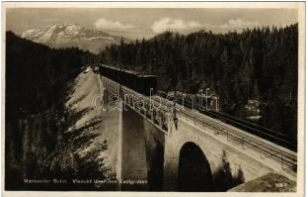
41826. ** Mariazellererba, Viadukt über d T2/3 3000
