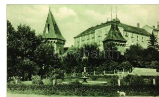
40680. ☒ 1931 Pannonhalm, Apátság kaputorn T2 1200
