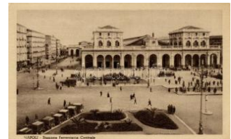
42169. * Napoli, Napoli; Stazione Ferroviaria C T21000
