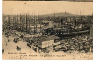
41924. 1905 Marseille, Vue générale du Vie T2/3 2600
