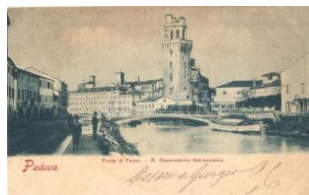
42195. ** Padova, Ponte di Ferro, R. Osserva T2/3 1400
