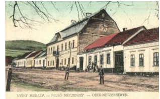
41214. Felsőmecenzéf, Obermetzenseifen, Vy T23000
