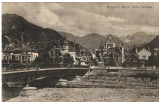
42110. * Bolzano, Bozen (Südtirol); Ponte de T2/32000
