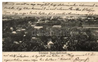
41604. * Nagyszőlős; (ázott / wet damage) T4 T4 1000
