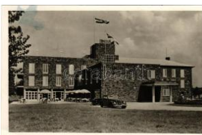
40286. ☒ 1941 Balatonföldvár, Üdülő étterem, a T21000
