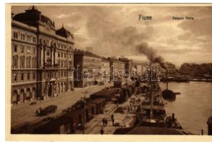
41662. * 1911 Fiume, Rijeka; Palazzo Adria / T2/3 2000
