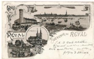
42339. 1898 (Vorläufer) Tallinn, Reval; Der T3/4 5000
