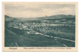
41268. Petrozsény, Petrozsény; Vedere gen T438000
