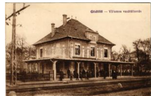
40522. ☒ 1918 Gödöllő, Hévíz Villamosvasút Fe T2/34200
