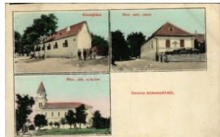
40772. 1912 Szakadát (Tolna), községháza, R T26000
