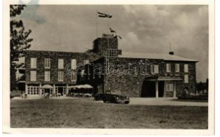
40163. ☒ 1941 Balatonföldvár, Üdülő étterem, au T2 900
