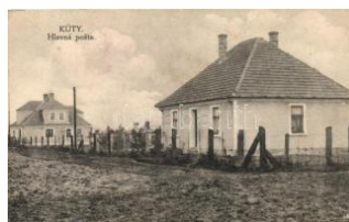
41518. Jókút, Kúty; Posta / Post Office (EB) T3 3600
