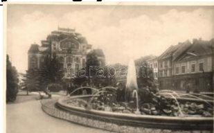
41560. * Kassa, Színház és szökőkút / Theatre T2 1000
