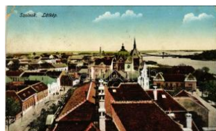
40814. 1916 Szolnok, zsugorház (szakadás) T3 1000
