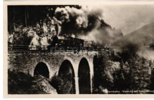
42172. Tauernbahn, Viadukt mit Schnellzug T2/2600
