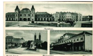
40690. 1938 Nyíregyháza, vasútállomás, Kos T28000
