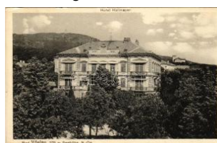
42133. * Bad Vöslau, Hotel Hallmayer (EK) T 2/3 2600
