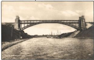
42583. ** Hochbrücke b . Levensau / Levens T1 2000
