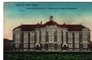
42388. Ostrava, Morav ská Ostrava, Máhrisc T2/300
