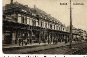
41110. Szolnok, vasútállomás. Faragó Sánd T32000
