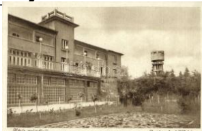
40728. ✱✱ Hévíz, Postás g yógyüdülőház, víztör T21400
