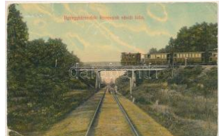
40926. 1909 Nyíregyháza, Nyíregyházvidék T3 15000
