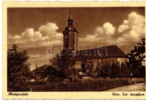
40217. ** Abaujszántó, Római katolikus templom T2/3 1000
