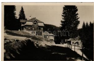
41353. ✱✱ Hargitafürdő, Hargita-fürdő, Hargh T2/31200
