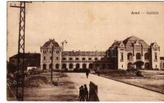
41239. 1918 Arad, Indóház, építkezés, vasú T2/35000
