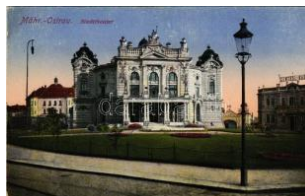
42386. Ostrava, Morav ská Ostrava, Máhrisc T2700
