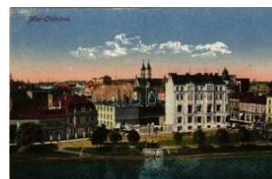
42384. Ostrava, Morav ská Ostrava, Máhrisc T2/300
