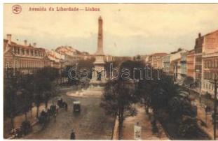
42594. Lisboa, Lisbon; Avenia da Liberdade T12000
