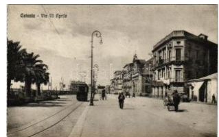
43502. * Catania, Via VI Aprile / street view, tram T3 200
