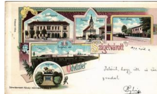
41214. 1899 (Vorläufer) Szigetvár, Takarékpénztár T35000
