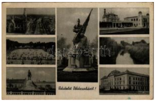
40327. * 1944 Békéscsaba, Vasútállomás, Hőső T31000
