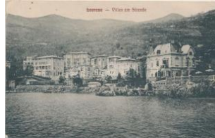
42718. * Lovran, Lovrana; Villas (EK) T2/3 T2/3 1200
