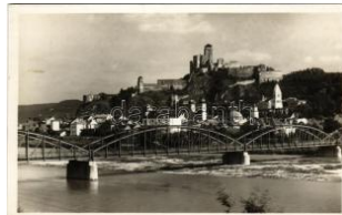
42516. * 1937 Trencsén, Trencsén; vasúti híd és T2 1200
