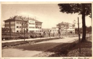
41119. 📧 Sopron, Lövér szálló T2 T2 1000
