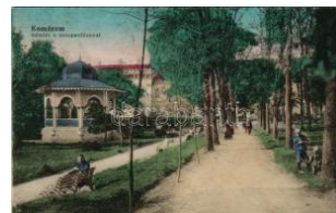
42226. * Komárom, Komárnó; Sétatér, zenepav T31200
