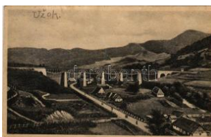
42627. 1924 Uzsok, Uzo k, Uzhok; viadukt, T2/3 1800
