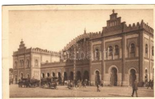
43655. Sevilla, Estación de Cordoba / railw T4 1000
