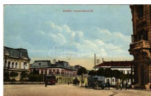
42208. Kassa, Kossuth tér; Ferenc József tér, viadukt T3 3000
