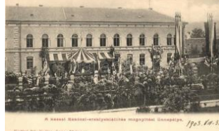
21421. Kassa, Kosice; Rákóczi ereklyek kiállítása 4000
