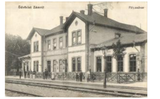
21289. * Zám, Sameschdorf; vasútállomás / railw 10000
