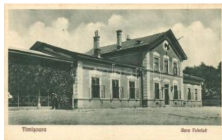
21251. ✪ Temesvár, Timisoara; Gyárvárosi vasútállomás 4600
