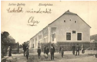
20827. ☒ Szilásbalhás, Mezőszilas; Községháza. 2800
