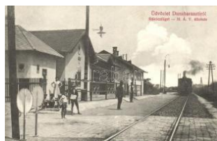
20425. ☒ Dunaharaszti, Rákóczi közvilágítási MÁV vasútá 14000
