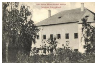
21672. * Sztropkó, Stropkov; Gróf Huszár Rákóczi 6000
