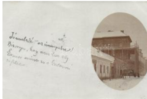
20537. ☒ 1899 Kalocsa, Katolikus legényegylet, ép 3000
