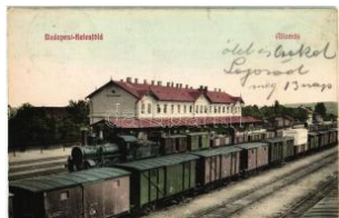
20275. ☒ Budapest XI. Kelenföld, vasútállomás, g 6000
