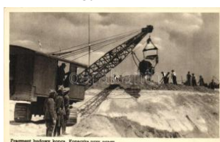
22410. ** Fragment budowy kopca. Kopaczka pp 1600
