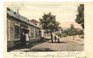
21694. ☒ Torna, Turna nad Bodvou; Fő utca, Stein 9000
