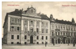
20200. * Budapest III. Óbuda, Előjárósági épület, 2400
