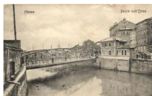
21818. Fiume, Ponte sull'Eneo / bridge (f) T2/3 1600
