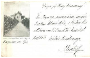
20059. ☒ Balatonalmádi, L. uja lak (kis szakadás) / 3000
