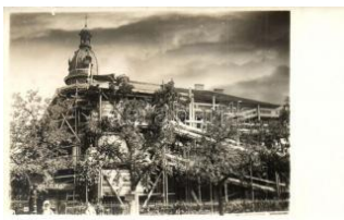
20323. * Budapest XIV. Ste fánia úti építkezés, Am 3000
