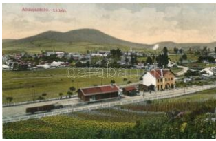
20015. Abaujszántó, Vas útállomás Tokaji-hegyv 4600
