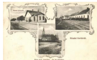
20554. ✱ Kerta, vasútállomás, Római katolikus és 8000
