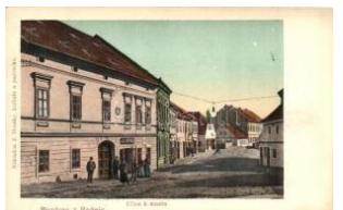
22220. ** Radna, Radnic; Ulice k mostu. Naklade 4000
