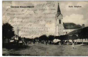
20772. ✉ 1908 Kisújszállás, Katolikus templom T2/3 4600
