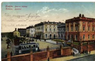
22282. ☒ Kraków, Krakau; Dworzec kolejowy / T2/3 3000
