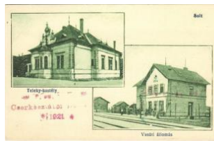
20953. ✳ Solt, vasútállomás, Teleký kastély T2 T2 4000
