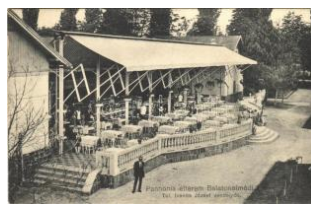
20077. * 1930 Balatonalmádi, Pannónia étterem T24200
