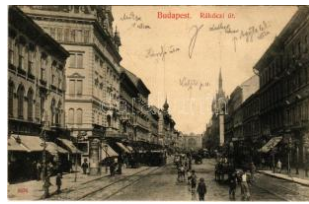
20328. ☒ 1910 Budapest V II. Rákóczi út, Metrop T24400
