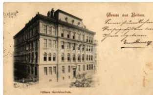
22179. ☒ 1900 Brno, Brünn ; Höhere Handelss T2/3 2000
