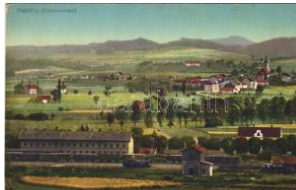
22096. * Fehring (Steiermark), Bahnhof / railway T33000
