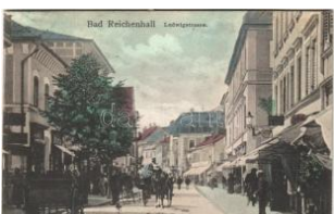
22673. 1907 Bad Reiche nhall, Lufwidstrasse T2 1800
