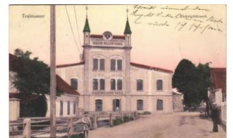
22452. ☒ Traismauer, Elektrizitätswerk, Martin M T3000
