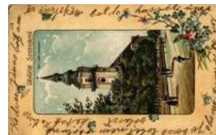
20946. 1904 Szolnok, Római katolikus templom T2/3 3600
