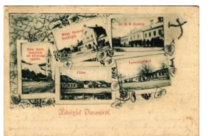
21783. ☒ 1900 Varannó, Vranov nad Toplou; T2/3 5500
