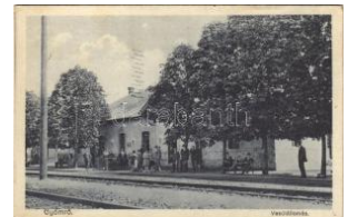
20548. Gyömrő, vasútállomás (EK) T2/3 T2/3 4000
