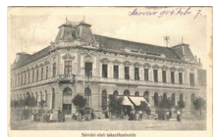
20846. 1904 Sárospatak, Első Takarékpénztár, S T2/33200
